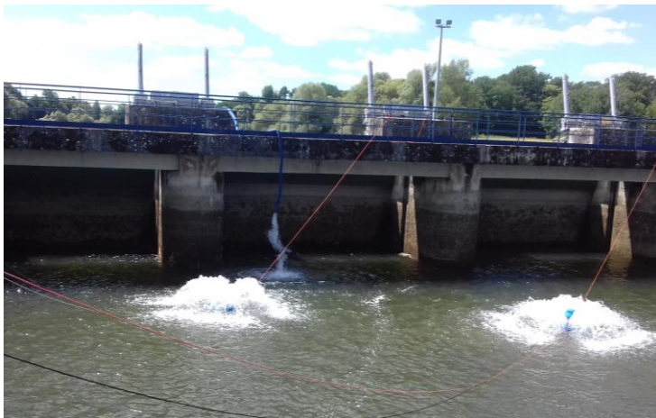
Pompes et aérateurs
