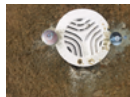
Barbacane avec sa nouvelle grille fixée
