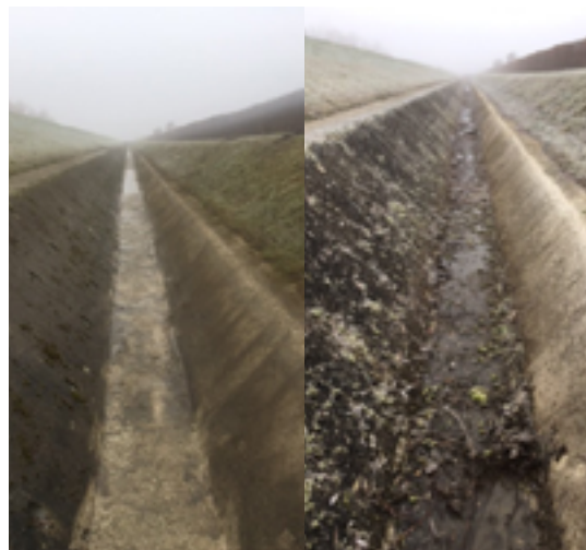
Entretien du fossé de pied de la digue de Brevonnes (Aube)
