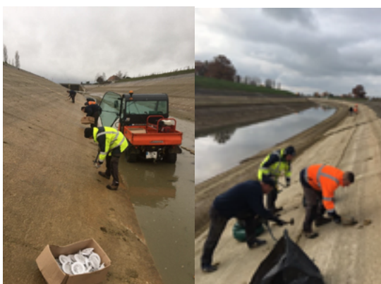
Nettoyage des barbacanes et pose des nouvelles grilles
