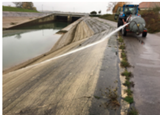
Nettoyage du parement
