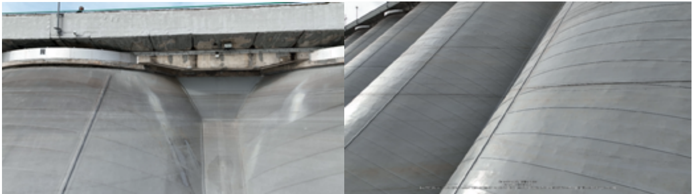
Images du parement amont du barrage de Pannecièrre, réalisées par drone.
