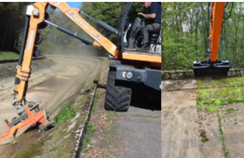
Démoussage mécanique du canal d'aménée Blaise (Marne)
