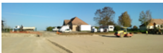
Préparation de la plate-forme
