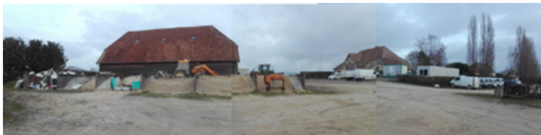
Bâtiments existants : grange de 270 m 2 à gauche et « lieu d'appel » de 200 m 2 à droite
