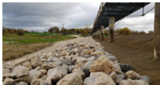
Figure 3 : Travaux de confortement du parement de la Digue de Rougemer du lac-réservoir du Der-Chantecoq. Source : Seine Grands Lacs.
