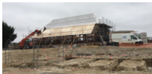
Réhabilitation de la grange
