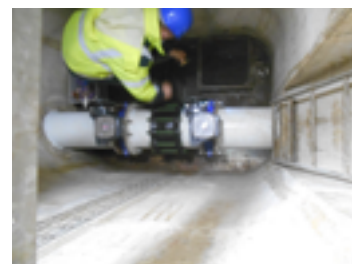
LT5, remplacement vanne de 300 du débit réservé
