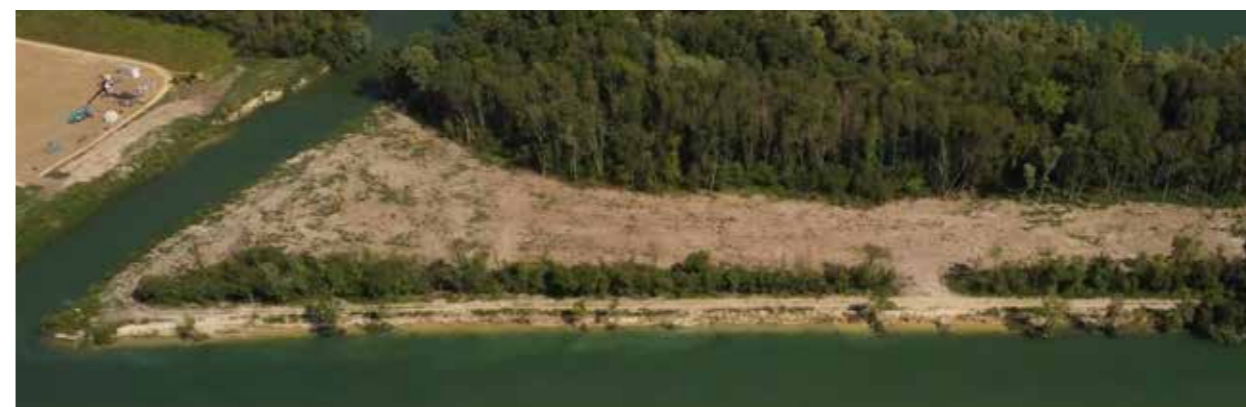
Frayères au premier plan, zone de la future digue juste derrière et emplacement de la future station de pompage sur la gauche
