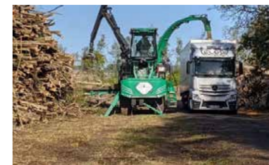
Sur le site Muscardin, la machine broie le bois pour qu'il soit utilisé en bois de chauffage (dans des établissements proches du projet). Photo : Seine Grands Lacs
