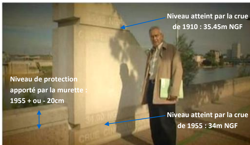
Le repère de crue situé quai Blanqui à Alfortville (94), en rive droite de la Seine. Source : CG 94 Ohval ! 18, Spécial crue centennale, 2010
