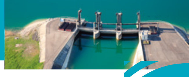
Déversoir d'extrémité du canal d'aménée Seine
